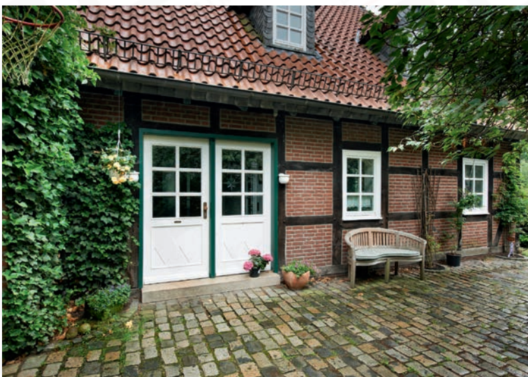
Energiatakarékos fűtés régi épületekben – akár kiegészítő szigetelés nélkül is (ellenőrzött hőleadók esetén).
