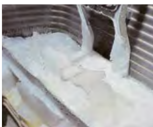
Jégképződés a tálcáfűtés nélküli kültéri egységen
